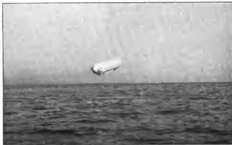
Das Luftschiff erhebt sich von der Wasserfläche.
